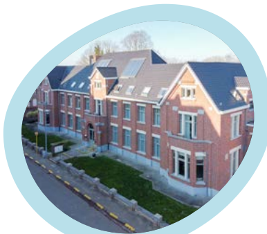
Maison de Vie et de Soins Site La Châtellenie Warneton
