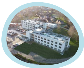
Maison de Vie et de Soins Site Paul Demade Comines
